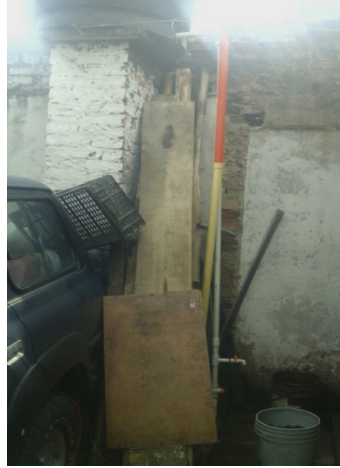
Foto 3. Tubería que conduce el agua del aljibe al tanque de la parte superior.
